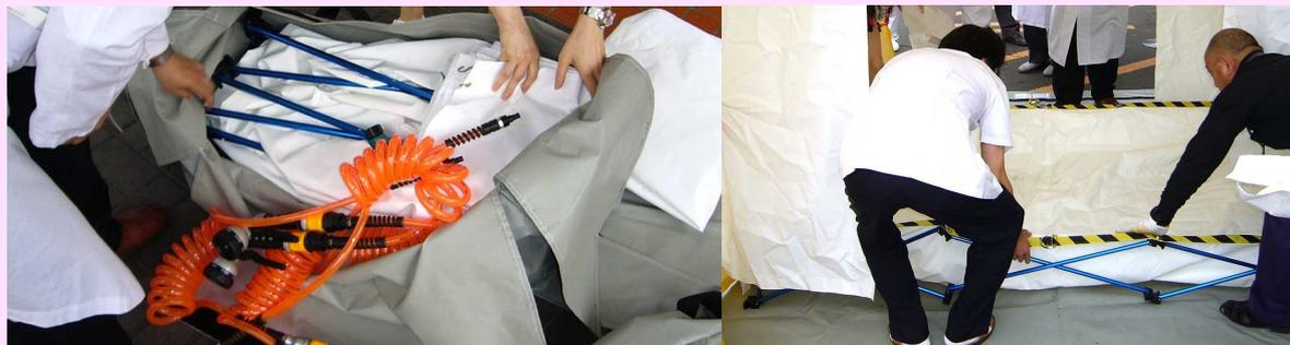
受水槽を引き延ばしテント内に設置します。
